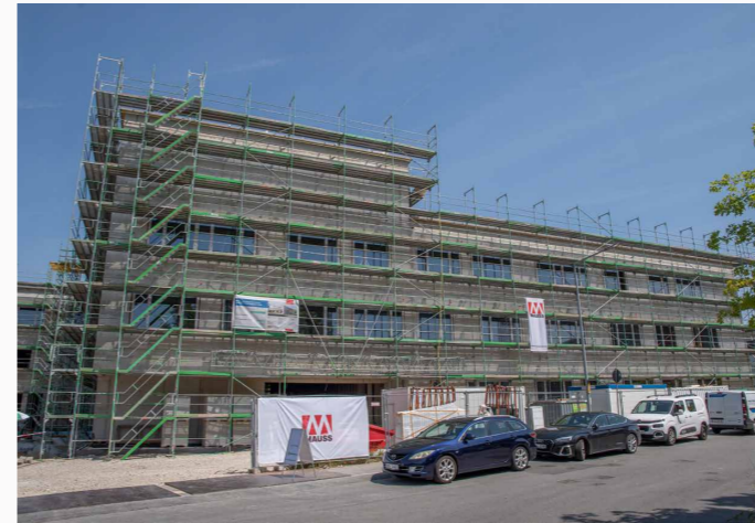
Blick auf den Rohbau der neuen Grundschule Bildquelle: Julia Römer, wbg Nürnberg
