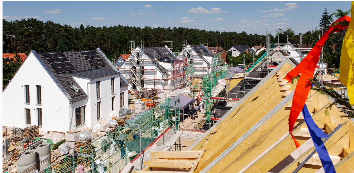
Doppelhaushälften in der Bischofsweiherstraße.
