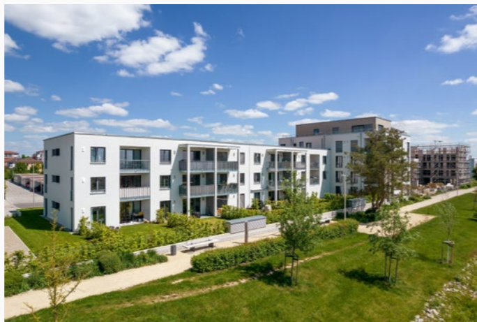
Luftbild des Neubaus in der Carl-von-Ossietzky-Straße.
