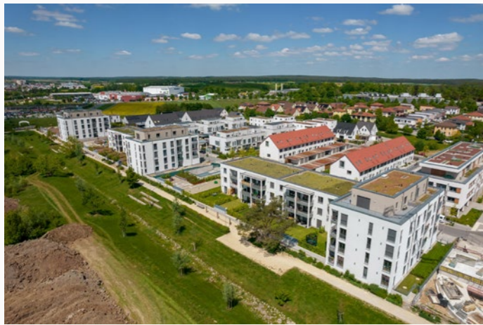
Luftbild des Neubaus in der Carl-von-Ossietzky-Straße.
