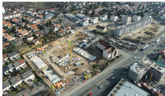
Es geht voran im Westwinkel. Im Vordergrund die Baustelle für die Eigenheime des ESW Baurträger. Im Hintergrund rechts die bereits 2021 fertiggestellten öffentlich geförderten und frei finanzierten Mietwohnungen des ESW.
