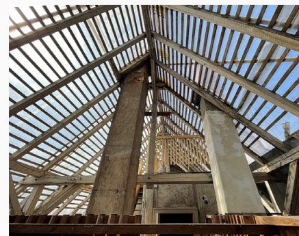
In der Denisstraße wird das Dach nach Denkmalschutzvorgaben modernisiert. Fotos: Archiv wbg-Nürnberg
