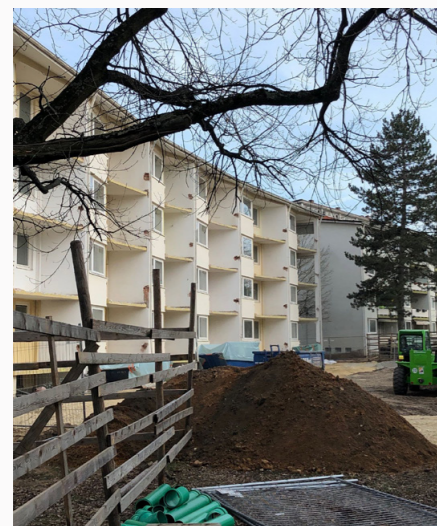
Durch eine Aufstockung werden in der Söderblomstraße fünf neue Wohnungen geschaffen.
