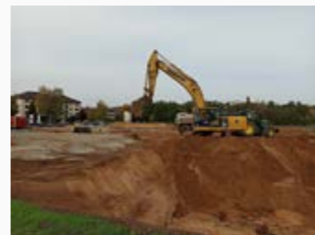
Seit Mitte Oktober rollen die Bagger im Osten der Gemeinde Buckenhof. Zwischen den Straßen Neukreut und Obere Büch entsteht ein Wohnquartier mit ambitionierten ökologischen und sozialen Standards. Foto: Joseph-Stiftung
