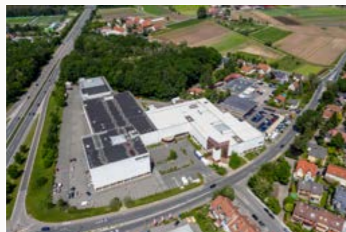
Das Gelände des Francken Wohnlands/Möbel Höffner. Der Abriss des Altgebäudes soll bis Ende 2020 erfolgen, anschließend startet das Großprojekt von BAYIKO in die nächste Phase. Foto: Archiv Kamran Salimi – FürthWiki
