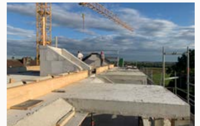
Eine Aufnahme der beiden Mehrfamilienhäuser im nördlichen Teil des Grundstücks, bei denen gerade die Arbeiten am Dachstuhl begonnen haben.
