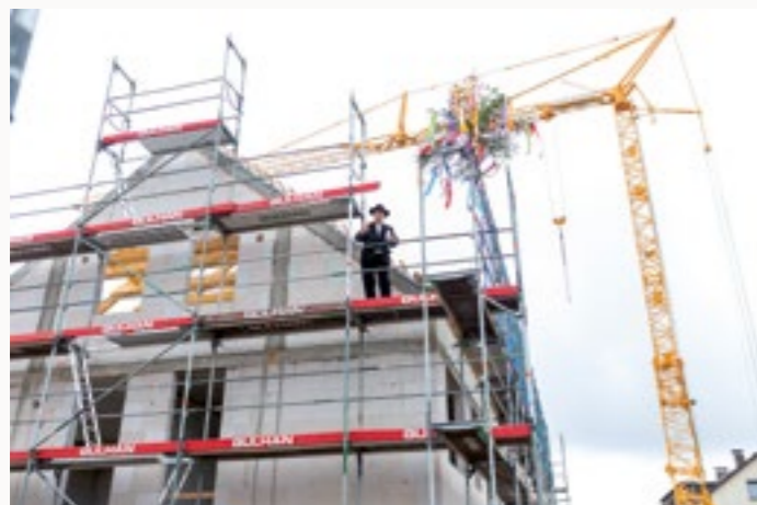
Richtspruch durch den Zimmermann der Firma Albert Holzner.
