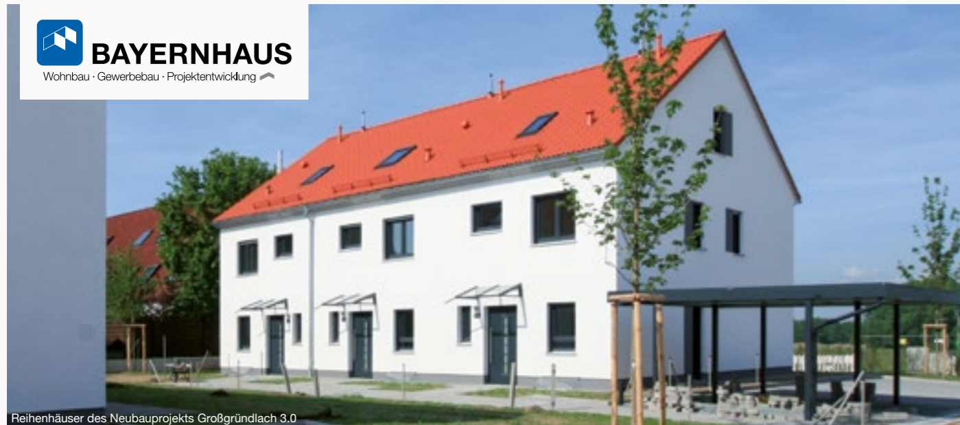
Reihenhäuser des Neubauprojekts Großgründlach 3.0
